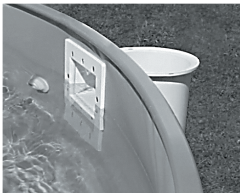
Zdj. 1 - skimmer zamontowany w ścianie asenu
